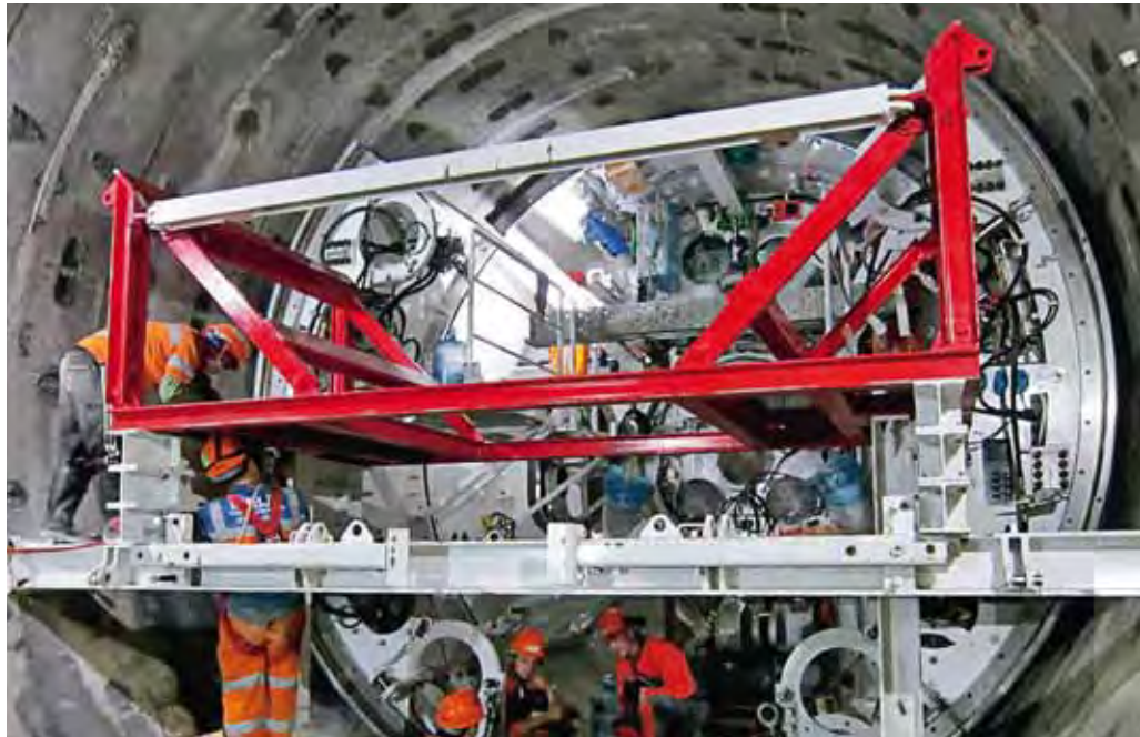
> La TDM en acción en el subsuelo de Hong Kong
