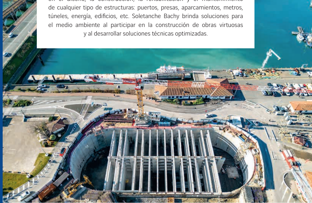
↑ Cimentaciones del aparcamiento del puerto de San Juan de Luz en Francia realizadas por Soletanche Bachy
